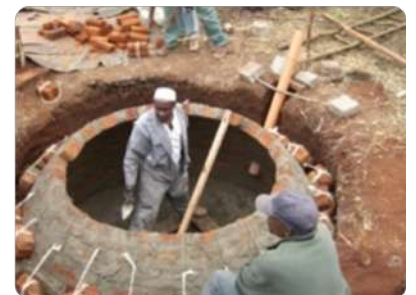
Bau von Biogasanlagen für Haushalte in Kenia
