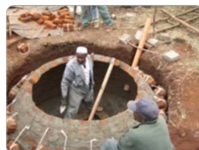
Bau von Biogasanlagen für Haushalte in Kenia
